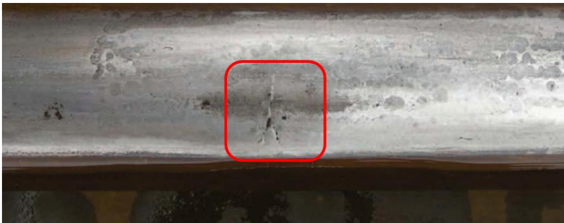
รูปที่ ง.10 รอยร้าวตามขวาง (transverse cracking)
