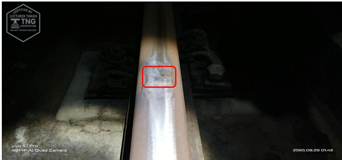
รูปที่ ง.9 รอยร้าวบนผิวราง (surface cracking)
